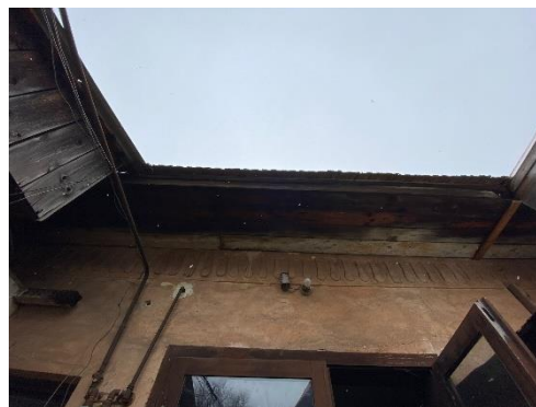
foto 65 Friza decorativă de la cornișă
