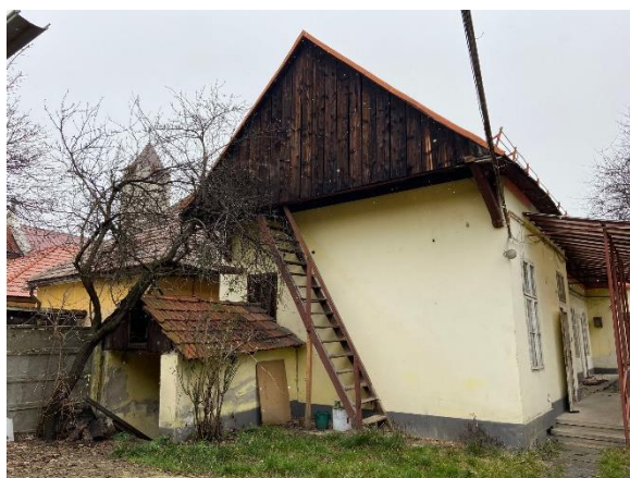
foto 47 Vedere acces acoperiș și subsol
