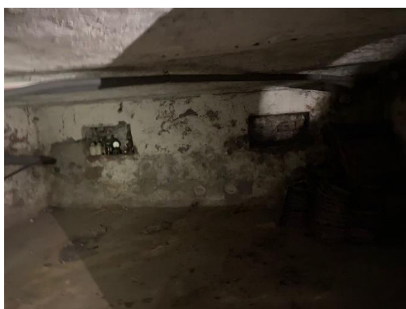
foto 49 Subsola realizat în etapa a doua de edificare
