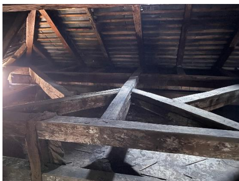
foto 56 zona nordică a șarpantei
