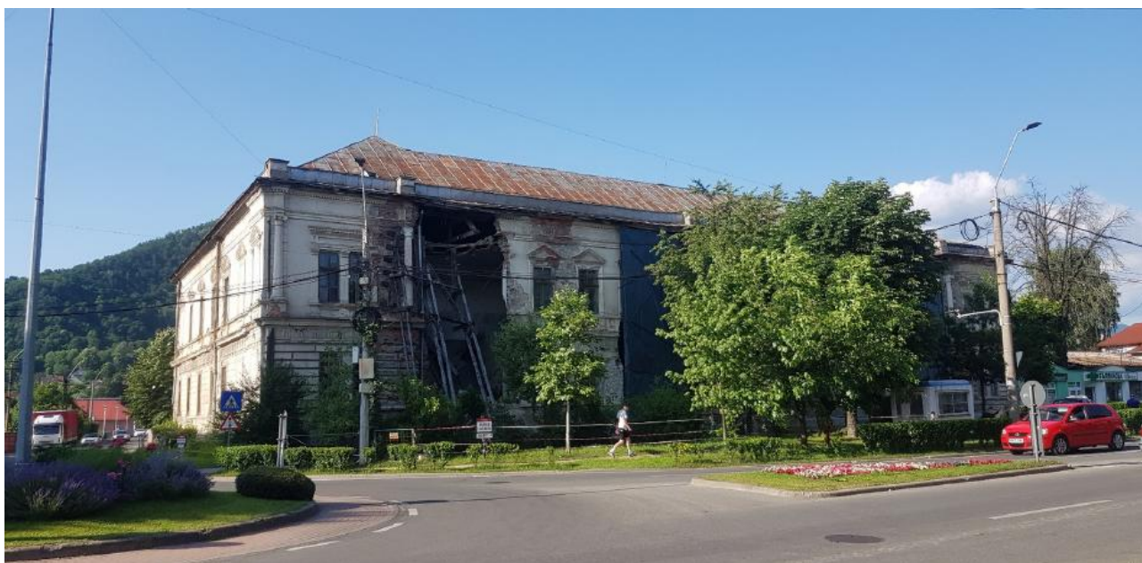
Fig. 6 - Fațada principală a clădirii monument.
