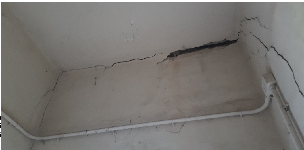
foto 58- porțiune de planșeu deja prăbușită peste coridorul etajului- 2023
