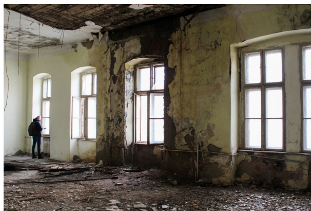
foto 54, 55, 56- sălile de la etaj afectate de umiditate- foto 2018 (traveile afectate sunt azi deja prăbușite)
