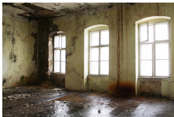
foto 54, 55, 56- sălile de la etaj afectate de umiditate- foto 2018 (traveile afectate sunt azi deja prăbușite)
