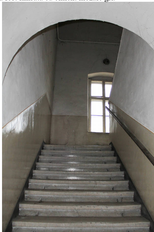
foto 72- scara principală din beton cu ciment mozaic
