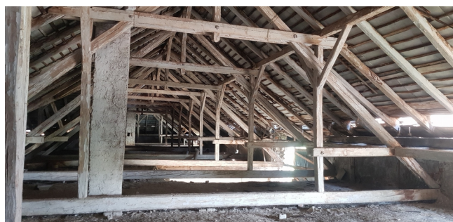
foto 63 (dreapta- 2018) și foto 64, 65 (jos- 2023)- fotografii din pod care ilustrează distrugerile progresive apărute după distrugerea învelitorii
