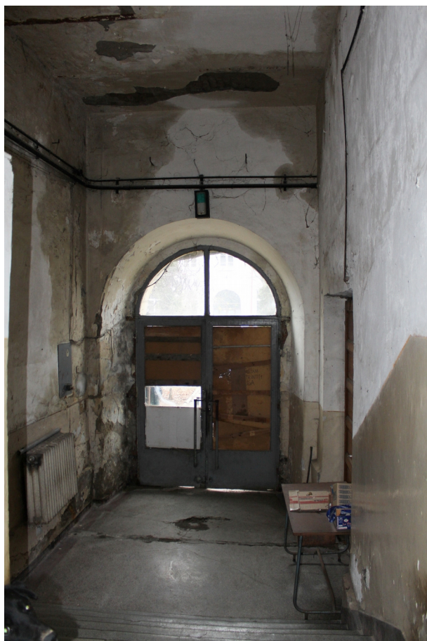
foto 61, 62- imagini din 2018 care arată parterul deja afectat grav de umezeală, după ce etajul fusese deja compromis
