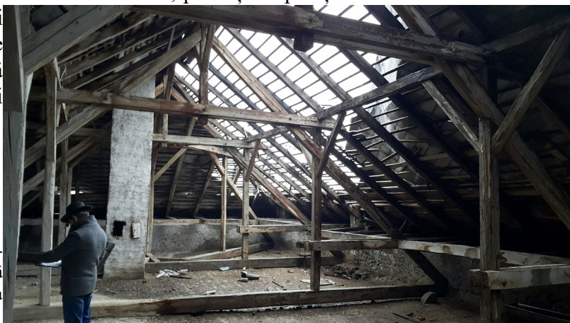
foto 63 (dreapta- 2018) și foto 64, 65 (jos- 2023)- fotografii din pod care ilustrează distrugerile progresive apărute după distrugerea învelitorii
