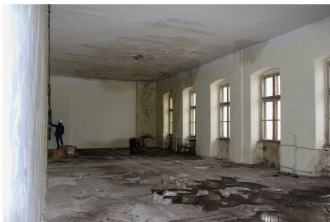
foto 61, 62- imagini din 2018 care arată parterul deja afectat grav de umezeală, după ce etajul fusese deja compromis
