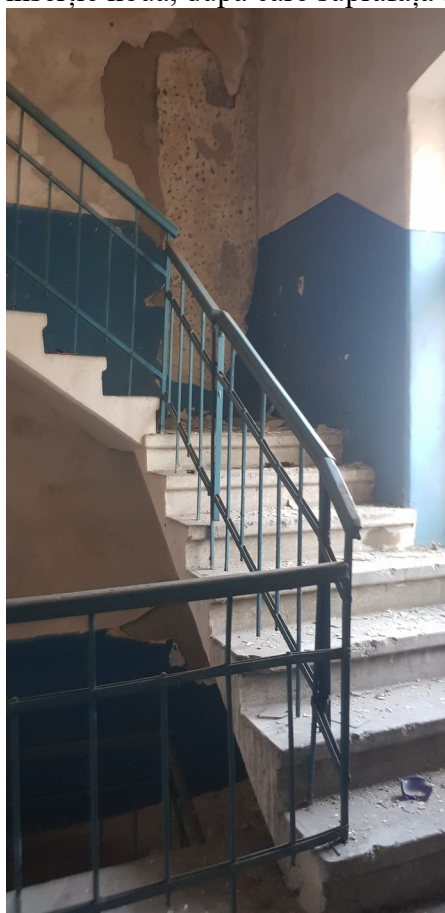
foto 71- scara secundară din beton cu ciment sclivisit
