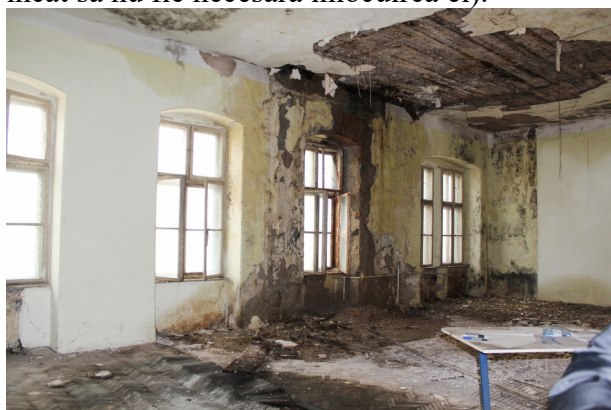
foto 54, 55, 56- sălile de la etaj afectate de umiditate- foto 2018 (traveile afectate sunt azi deja prăbușite)
