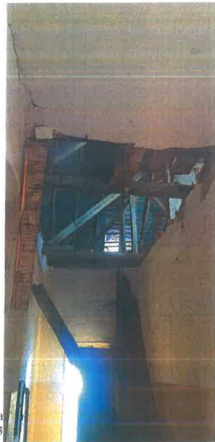
foto 58- porțiune de planșeu deja prăbușită peste coridorul etajului- 2023
