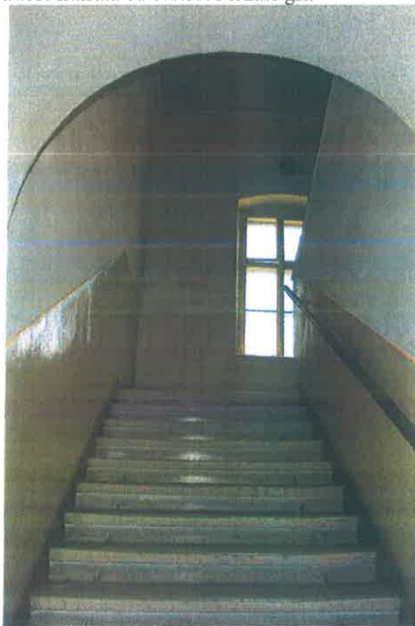
foto 72- scara principală din beton cu ciment mozaic
