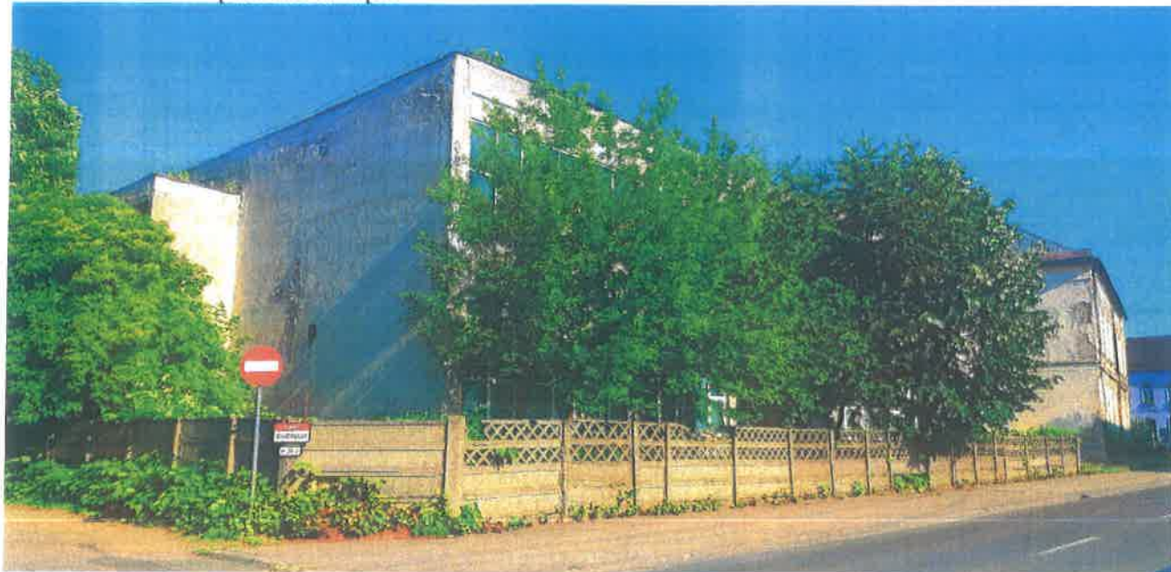
foto 41- proprietatea "Tricomar" văzută de pe str. Industriei, la intersecția cu str. Bujorului- iunie 2023
