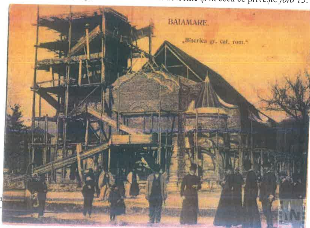
foto 17- biserica greco-catolică în șantier- 1910
