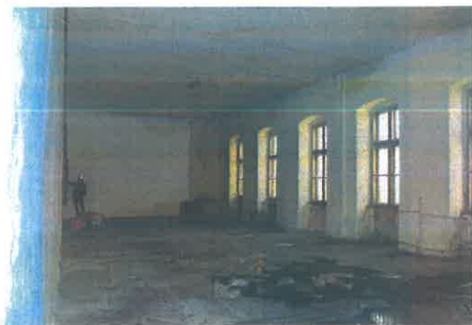
foto 61, 62- imagini din 2018 care arată parterul deja afectat grav de umezeală, după ce etajul fusese deja compromis
