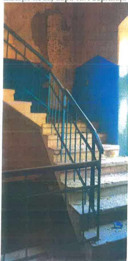
foto 71- scara secundară din beton cu ciment sclivisit
