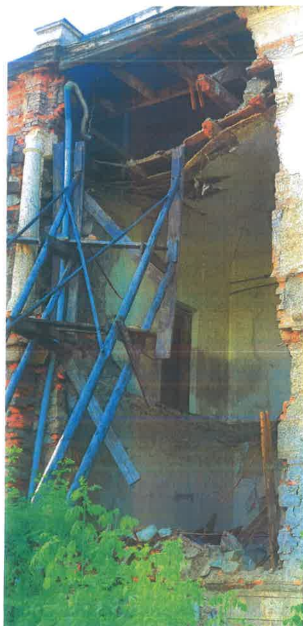
foto 46- una din cele trei travei prăbușite în 2018- foto 2023
